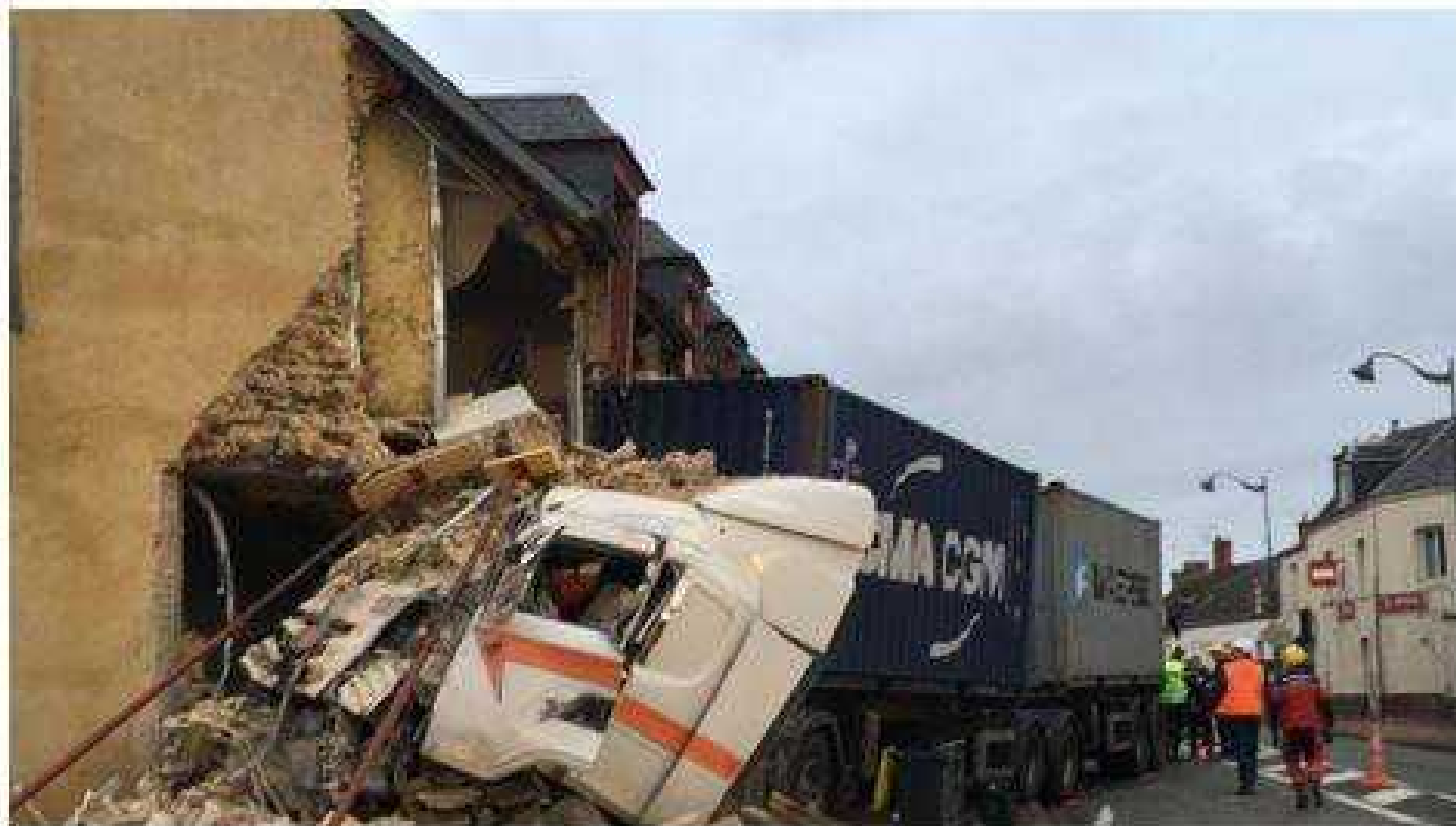
Sur la N10 (Eure-et-Loir) Un camion qui circulait en direction de Châteaudun s'est encastré dans une maison / © M.T - F3 CVDL
